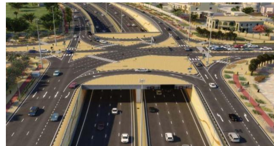
Al Rayyan Road Tunnel, Katar, Doha, ognioochronne zabezpieczenia konstrukcji
