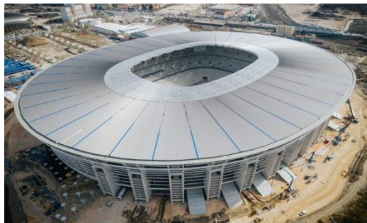
Puskas Ferenc stadion, Budapeszt, Węgry; wentylacji pożarowej i oddymiania
