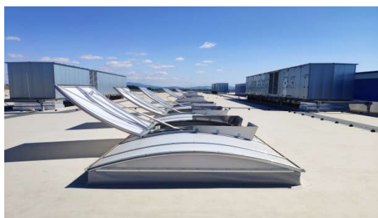
Zakład produkcyjny ZKW, Krušovce; Słowacja; systemy oddymiania
