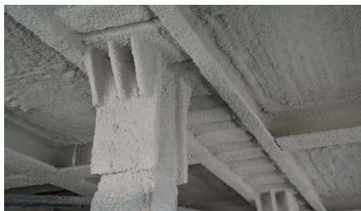
Hotel Riu Plaza España, Hiszpania, ognioochronne zabezpieczenia konstrukcji
