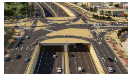
Al Rayyan Road Tunnel, Katar, Doha, ognioochronne zabezpieczenia konstrukcji
