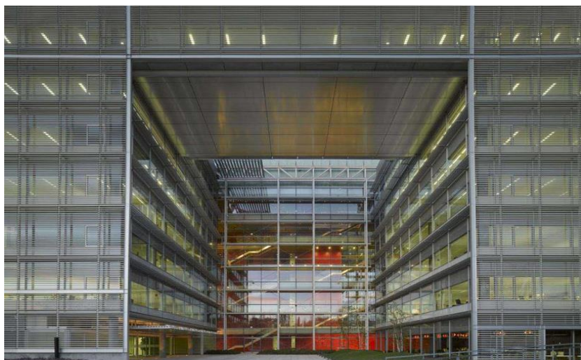
Siedziba Banco Popular, Hiszpania, ogniochronne zabezpieczenia konstrukcji
