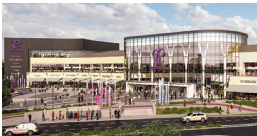
Galeria Posnania, Poznań; systemy wentylacji pożarowej i ogniochronne zabezpieczenia konstrukcji
