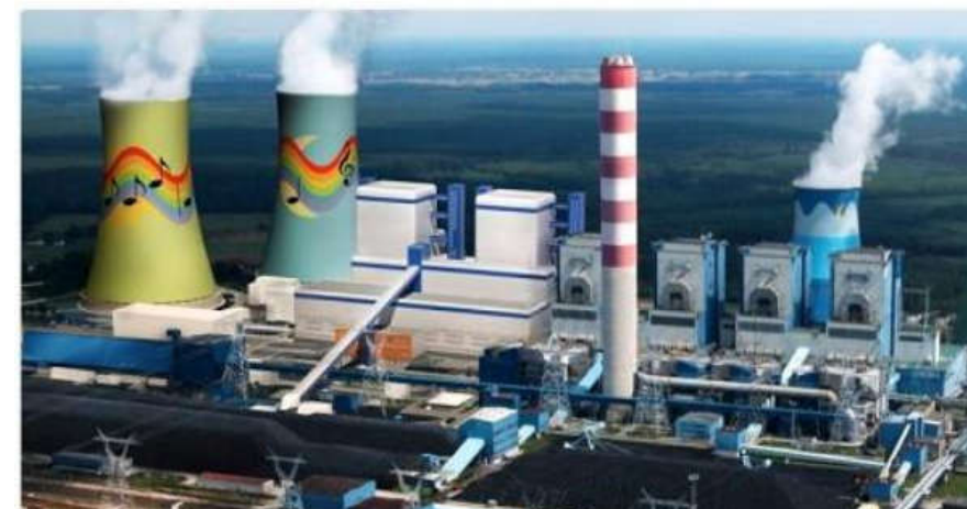
Elektrownia Opole Blok 5 i 6; systemy wentylacji pożarowej
